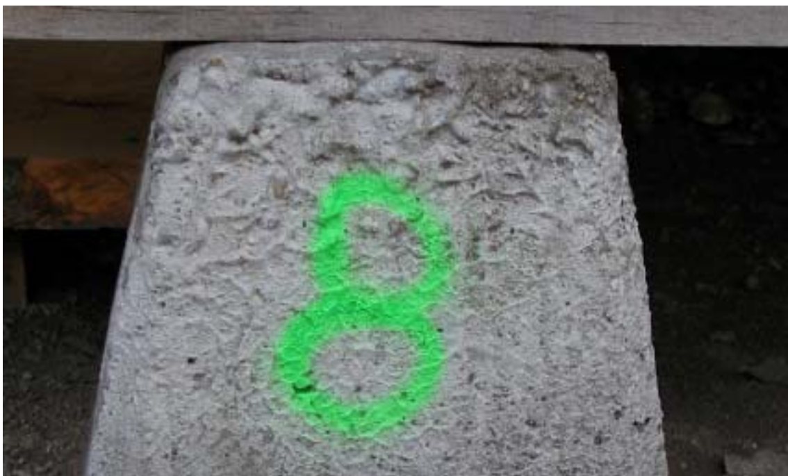
Slika 13. Označavanje betonskog stupčića fluorescentnom bojom
