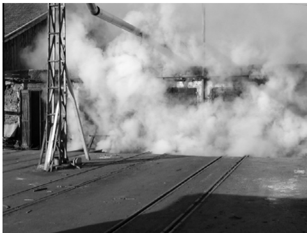
Slika 3. Sklop zidanih loše održavanih parionica
