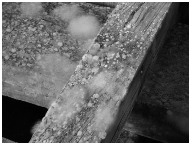
Slika 8. Posljedica rješenja sa slike 7 – zaražena drvena konstrukcija sa koje se zaraza prenosi na parenu građu Figure 8 Consequence from solution on figure 7 – infected wood construction can cause infection on steamed wood
